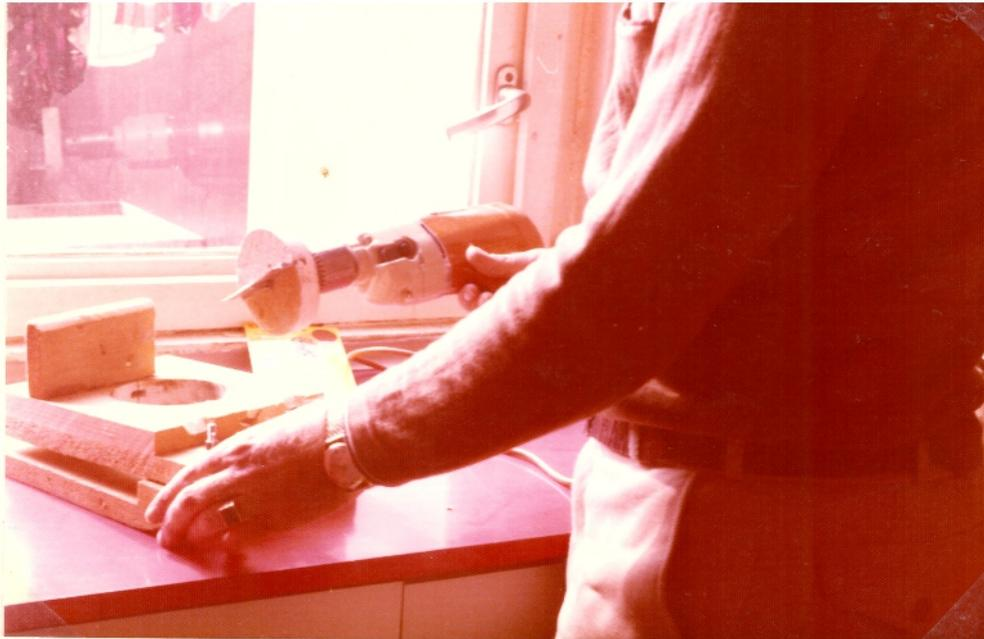
*Abbildung 8: Dritte Generation mit größerem Durchmesser und Handschutz. Durchmesser von 9,5 cm.*
