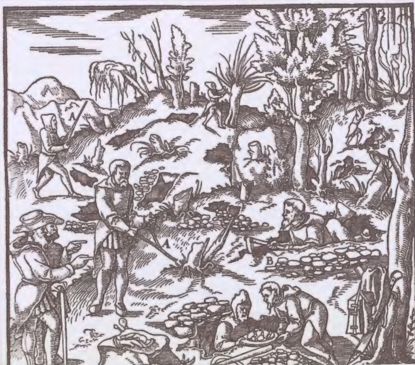
Aufsuchen der Gänge mit der Wünschelrute und durch Schürfgräben. Wünschelrute A Ein Schürfgraben B
