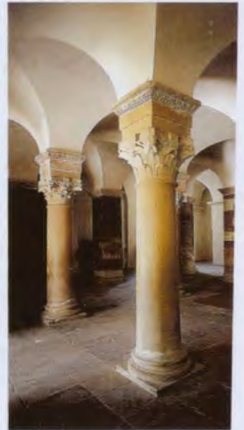
Kryptenartige Halle im Erdgeschoss des Westwerks mit vier mittleren Säulen, die von einem Pfeilerring umgeben sind. Die Säulen besitzen korinthische Kapitelle, die antike Formen rezipieren.
